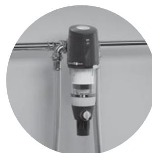
Sandwich-Anschlussarmatur mit Verschneideventil
